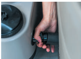
8) Collegare il blocco motore alla piscina con l'aiuto dei tre raccordi a vitare.
